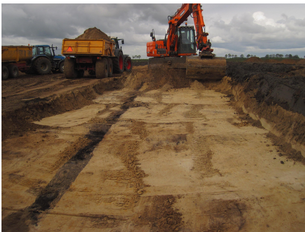
Figuur 15. Midwolda, Kerkelaan: foto genomen richting het westen tijdens het uitgraven van Locatie 4. De donkere streep is een recent spoor van een drainage.
